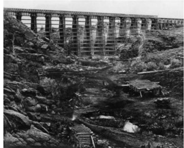
Железнодорожный мост Дэйл-крик, построенный компанией «Юнион пасифик» в штате Вайоминг в 1868 году. Длина моста составляла двести метров, над руслом реки он возвышался на тридцать восемь метров. В качестве основного материала для строительства использовалась мичиганская сосна, и мост стал типичным примером хищнического истребления американских лесов. На пике строительства железных дорог ежегодно вырубалось до тридцати миллионов деревьев
